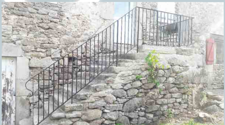
Une rampe d'escalier en fer forgé et des escaliers en pierres de taille.
